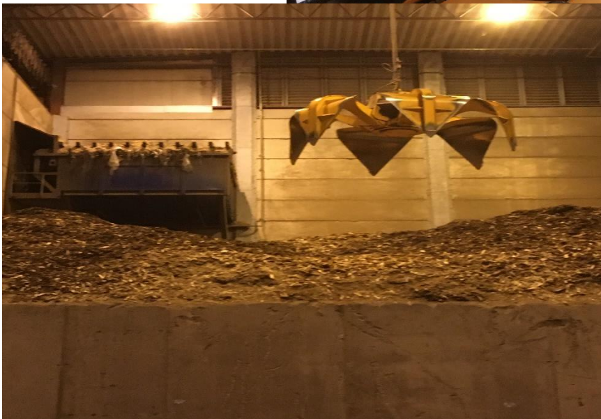
Här är "klon" som hämtar flis till flispannan. Det finns en panna som eldas med flis och en panna för sopor.
