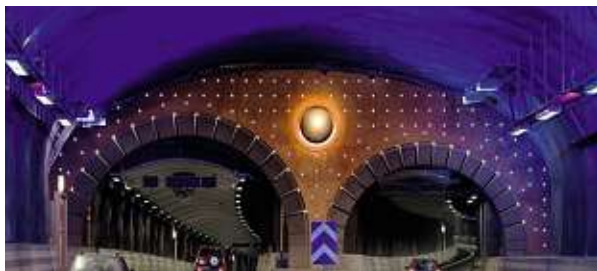
Södra länken i Stockholm, avfart Globen, är en av Leif Bolters utsmyckningar.
