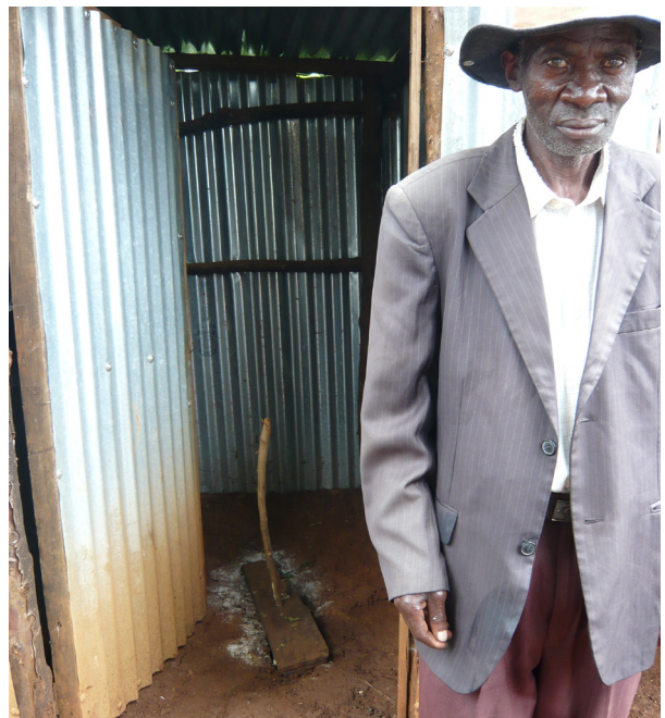
En latrin byggd av plåt med ett hål i marken.
